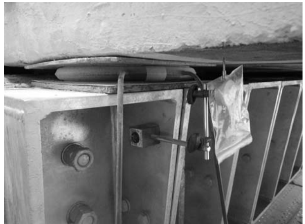
写真-9 ジャッキアップ完了後の状況
