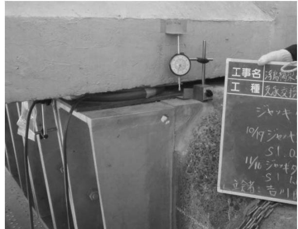
写真-4 高さ管理状況
