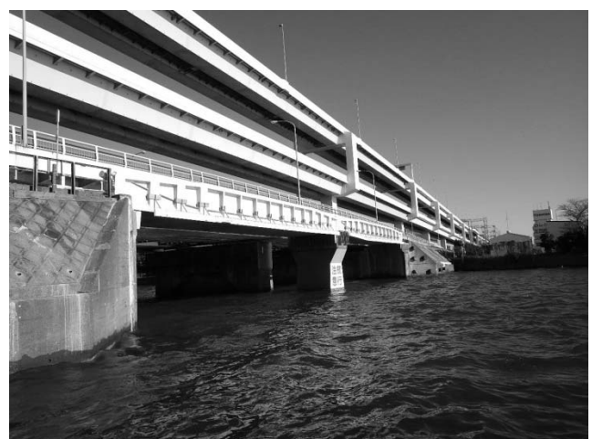
写真-1 浮島橋梁全景
