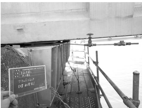
写真-3 フラットジャッキ設置状況
