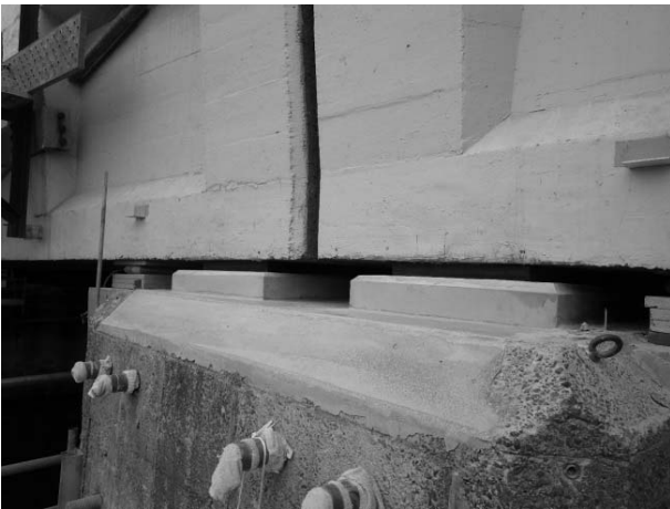
写真-6 はつり部復旧後P1橋脚支承部
