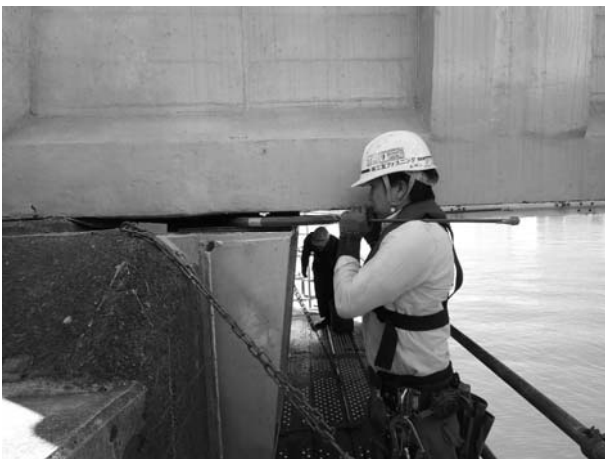
写真-8 フラットジャッキ配管作業状況
