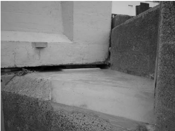
写真-7 はつり部復旧A2橋脚支承部
