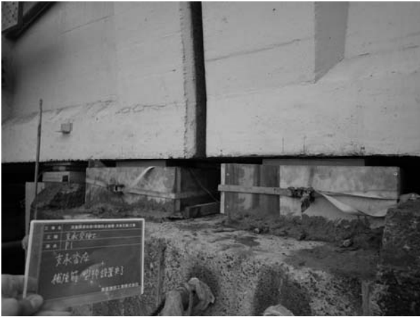
写真-5 沓座モルタル用型枠設置状況
