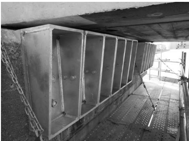
写真-2 縁端拡幅ブラケット設置状況
