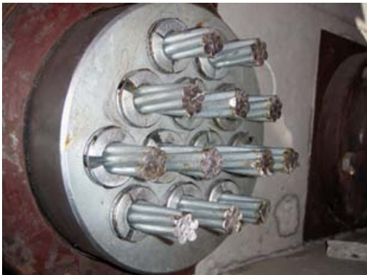
写真-10 PC鋼材および定着具の現況
