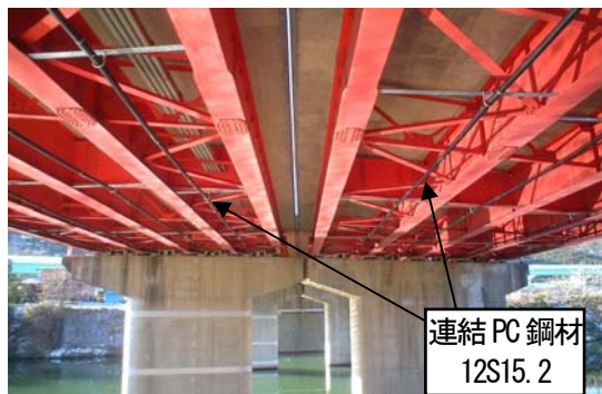
写真-1 連結PC鋼材配置
