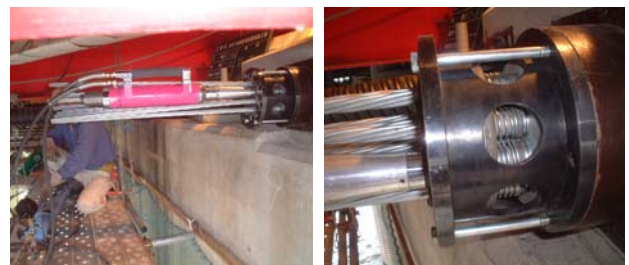
a) 緊張ジャッキ側全景 b) テンショニングキャップ 写真-5 緊張状況
