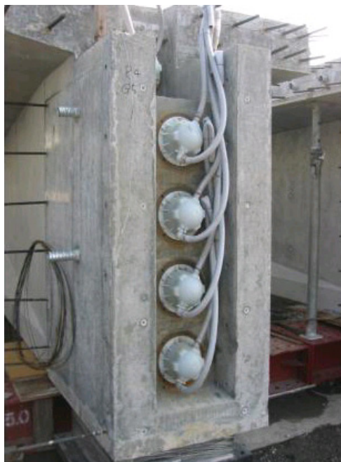
写真-3 樹脂製 GC の取付け状況
