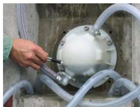
写真-4 グラウトの充填状況
