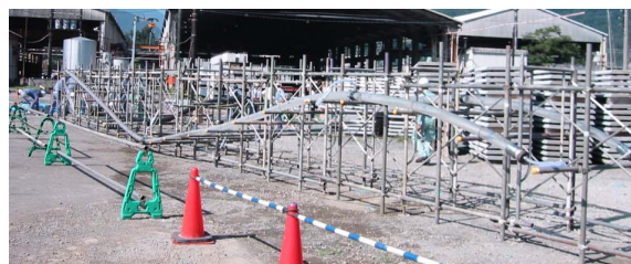
写真-2 基礎試験 B2 供試体全景
