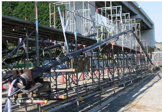
写真-3 供試体全景 (ケーブル長 60m)
