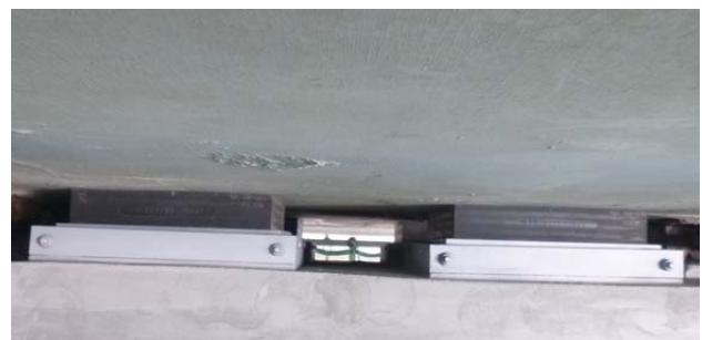
コンクリート橋への適用例
