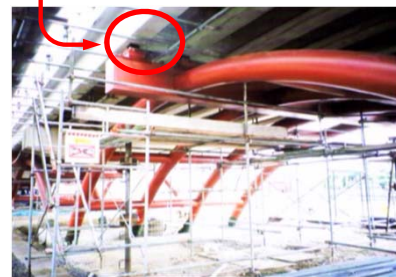
フラットジャッキ設置
