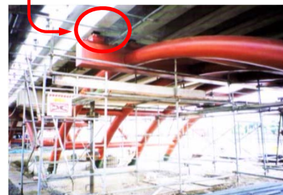
フラットジャッキ設置
