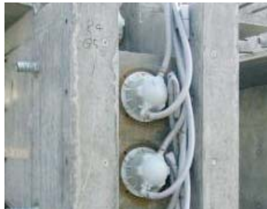
樹脂製グラウトキャップ取付け状況
