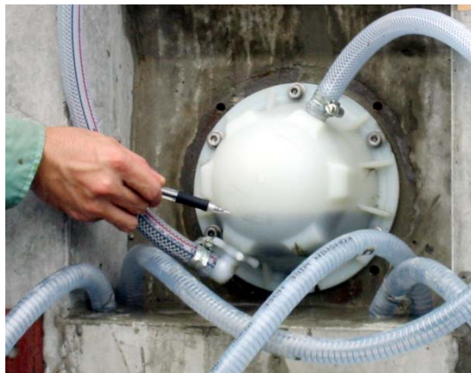
グラウト注入状況
