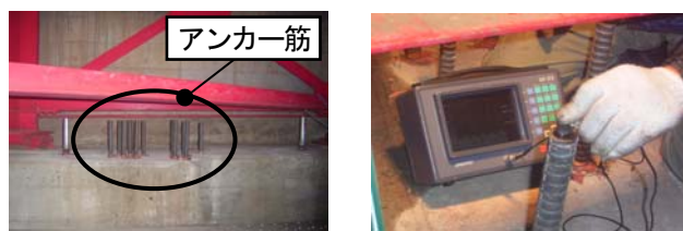
写真-3 定着アンカー筋と探査状況
