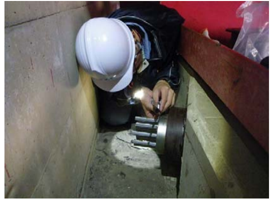
写真-12 ウェッジ出し測定状況
