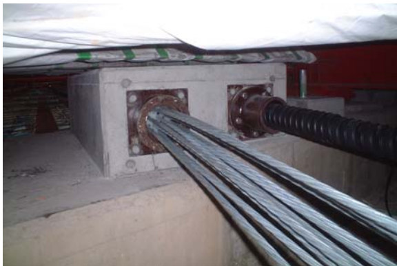
写真-4 PC鋼材の挿入
