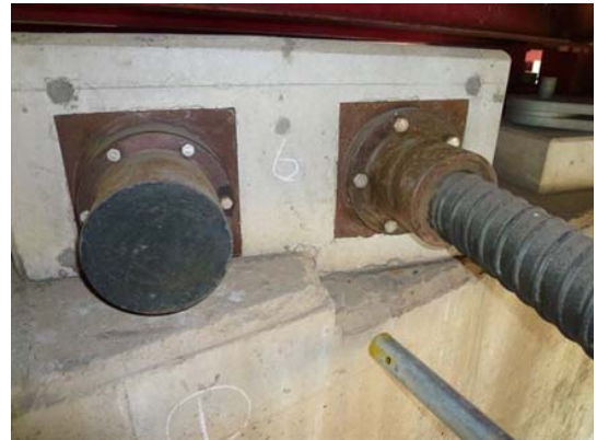
写真-6 定着部コンクリート
