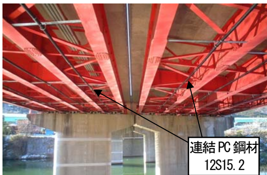
写真-1 連結PC鋼材配置
