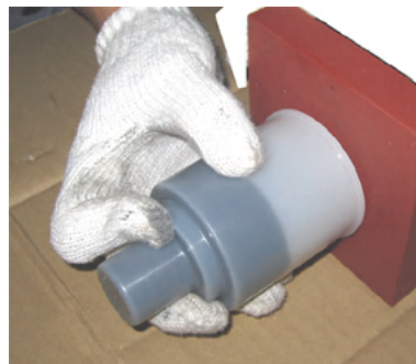
写真-4 取付け作業状況
