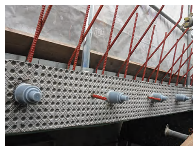
写真-8 現場状況
