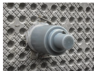
写真-9 現場状況
