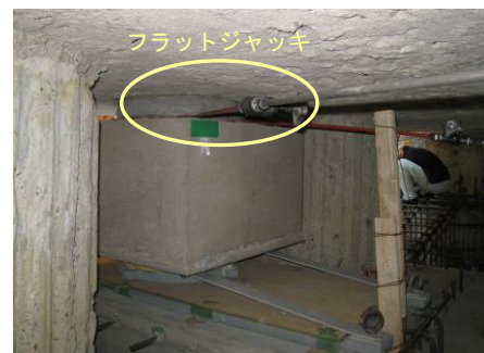
写真-7 基礎免震化工事
