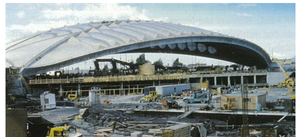
写真-2 モントリオールオリンピック競輪場屋根の撤去
