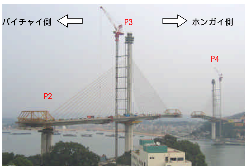
バイチャイ PC 斜長橋 (2005 年 12 月 FKK 撮影)
